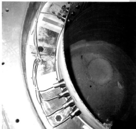
Installation der Anschlußbolzen im Ofenkopf eines Induktionstiegelofens zur Überwachung mittels SAVEWAY-System
