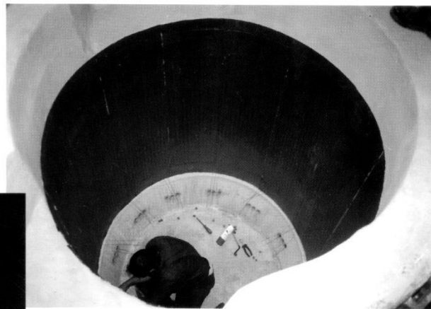
In einem Induktionstiegelofen eingebrachte Elektrodenplatten
